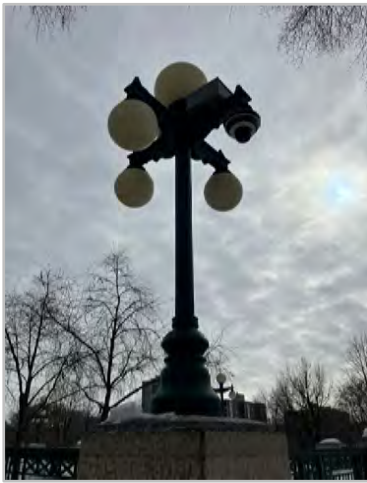
Nouvelle caméra de sécurité sur un lampadaire extérieur
