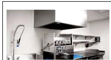
Figure 8: Hotte à condensation de type II dans l'aire de lavage
